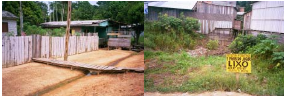
Foto 4.28 e 4.29: Vala de esgoto à céu aberto em Amaturá e despejo de lixo em área urbana. 2004.
